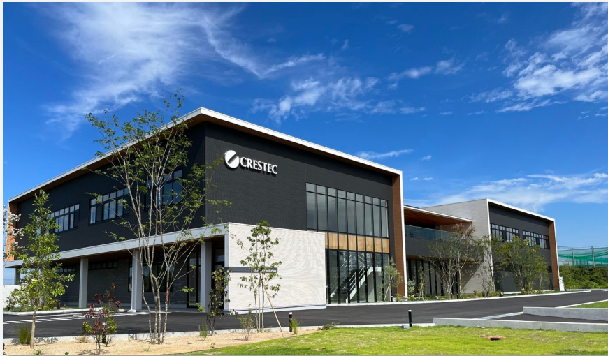
2022年10月 本社新社屋(浜松市中央区)完成
